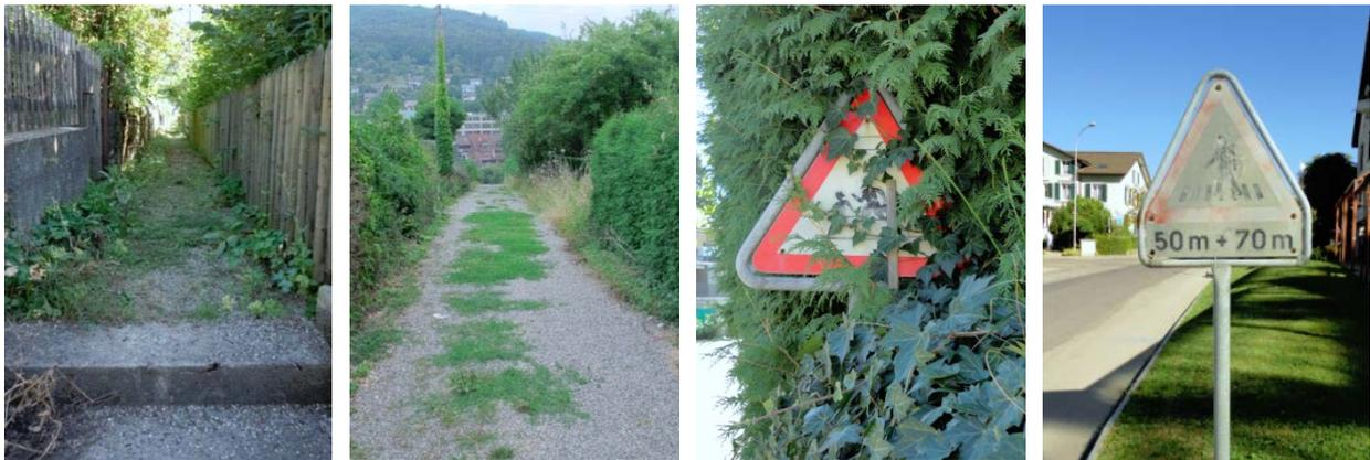
Abbildung 10: Unklare Funktion und Unterhalt von Fusswegen, überwachsene, schlecht erkennbare Signalisation
