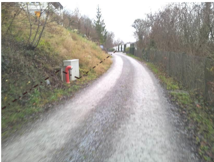
einspringende Parzellengrenze vor dem Hydranten
